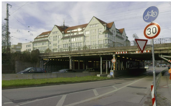
Abb. 3.1.16-1: Blick auf Eisenbahnüberführung Lindwurmstraße
