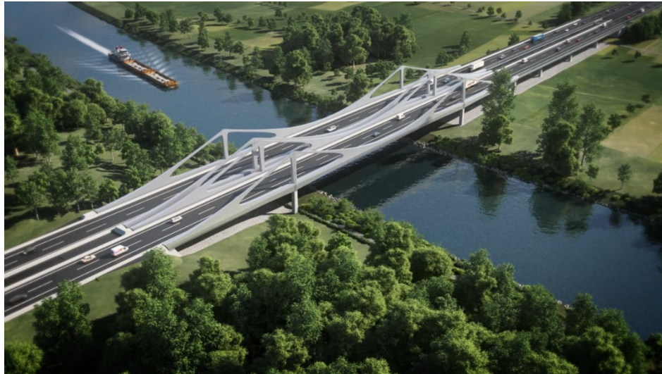
Abb. 2.1-26: Mainbrücke Mainflingen, BIM-Vorhaben der Autobahndirektion Nordbayern (Quelle: LAP Ingenieure).
