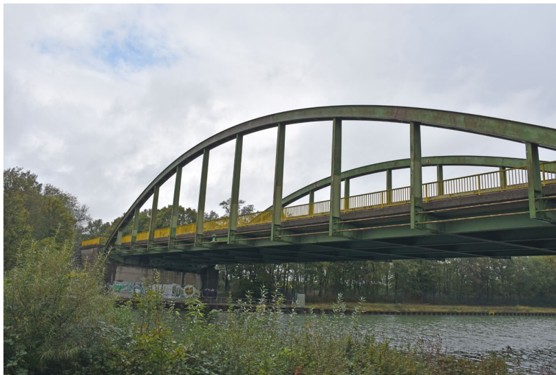
Abb. 3.1.13.-1: Foto der Drewer Brücke (©Projekt Bim.Ruhr)
