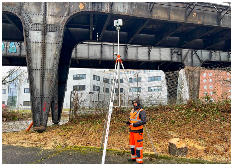
Abb. 3.1.10-1: 3D-Laserscan der Stahlviadukt Stützen aus verschiedenen Perspektiven.
