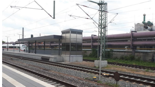
Abb. 3.1.9-4: Mittelbahnsteig nach dem Umbau.
