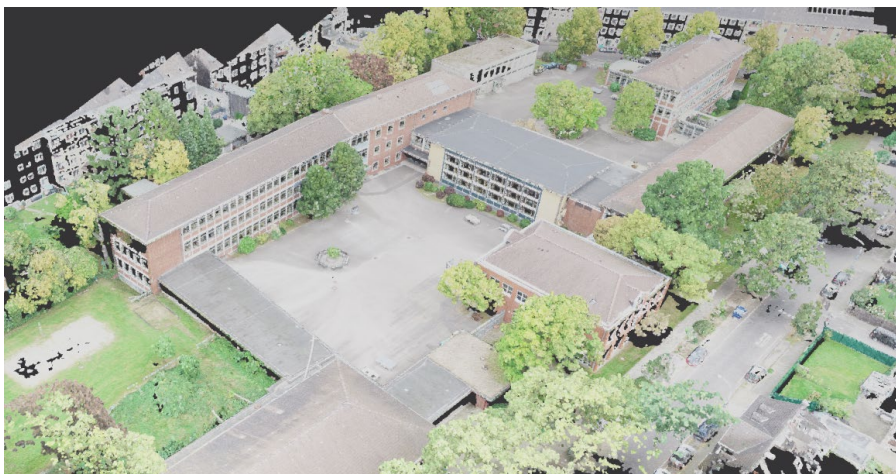
Abb. 3.1.21-9: Punktwolke des Gebäudekomplexes inkl. Randbebauung aus der Drohnenaufnahme, Quelle: KKI
