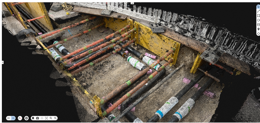
Abb. 3.1.19-3: Messergebnisse des 3D-Scannings in der Cloud
