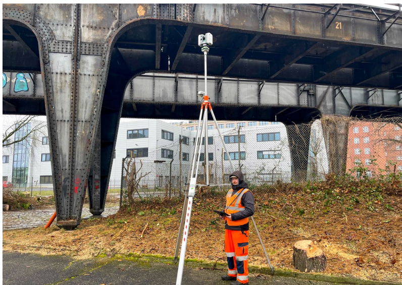
Abb. 3.1.10-1: 3D-Laserscan der Stahlviadukt Stützen aus verschiedenen Perspektiven.
